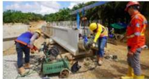
JEMBATAN JALAN INSPEKSI (PCI GIRDER)
