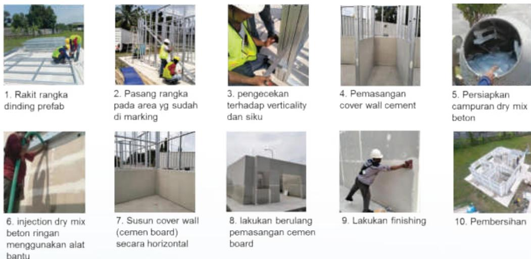
Gambar 2 Proses Pekerjaan *Infill Wall*
