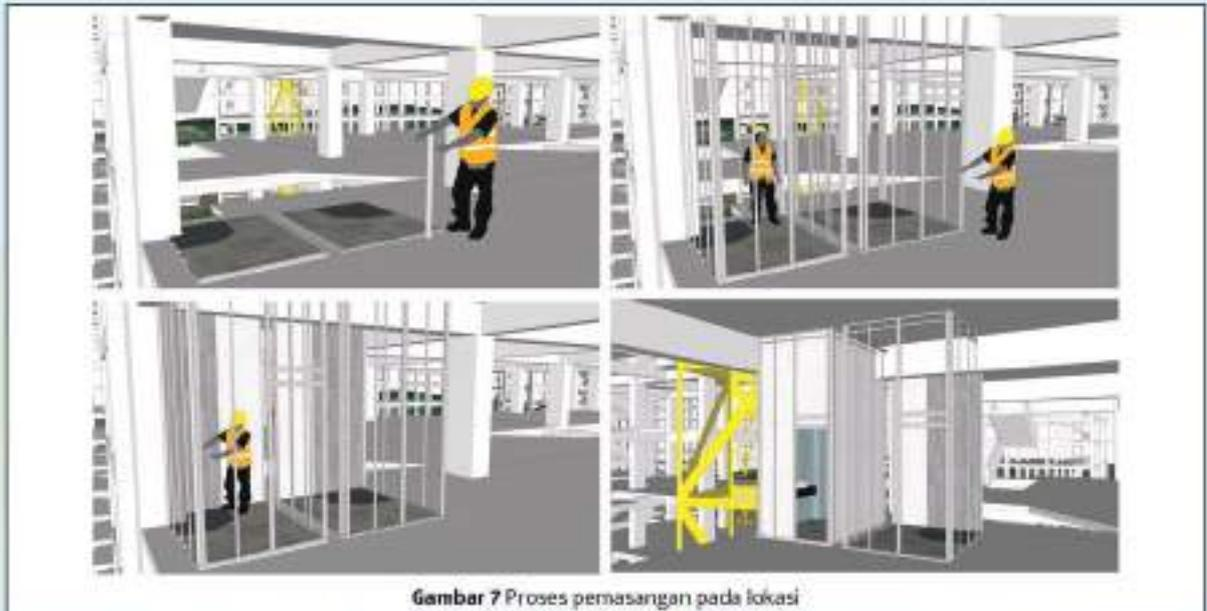
Gambar 7 Proses pemasangan pada lokasi
