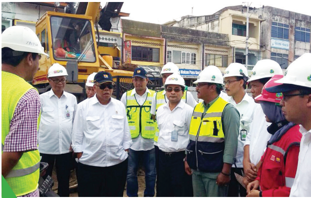
Kunjungan Menteri PUPR, Basuki Hadimuljono ke Proyek Abipraya Pembangunan Fly Over Simpang Surabaya, Aceh 24 November 2016.
