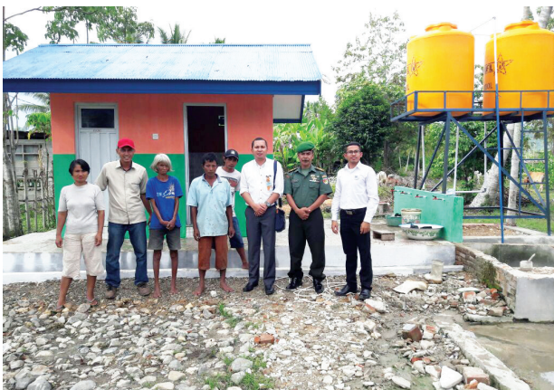
► Fasilitas MCK dan Sumur untuk sarana air bersih desa tertinggal di Gorontalo yang dibangun oleh Askrindo dan Abipraya.
