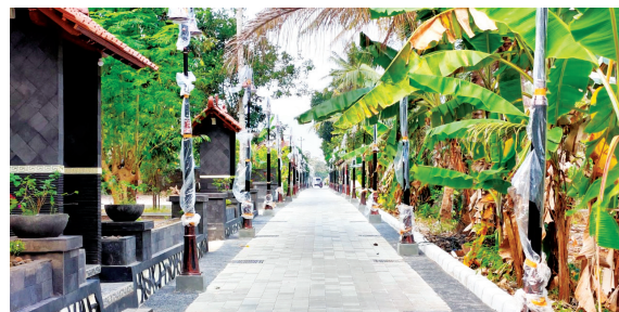
Pengerjaan jalan di Pemukiman Bojong yang telah rampung digarap Brantas Abipraya, kini menjadi viral di Magelang.
