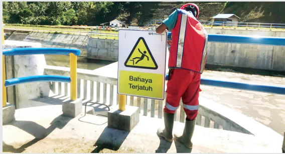
Safety Sign Installation, Image from Proyek Pekerjaan Pembangunan DI Salugan
