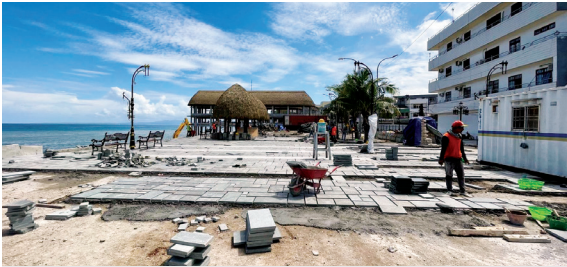
Bagian Pekerjaan Proyek Penataan Kawasan Kupang yang dikerjakan oleh Koperasi Karyawan Brantas Abipraya (KKBA).
