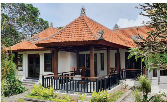
Tanggap darurat ruang isolasi COVID-19 di Bali, Brantas Abipraya merampungkannya selama dua minggu. Ini salah satu bangunan yang dipugar untuk ruang isolasi darurat.
