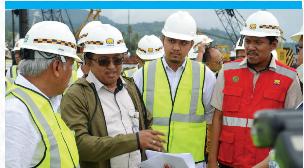
► Menteri PUPR, Basuki Hadimuljono meninjau Proyek Pembangunan Dermaga TNI AL Tawiri Ambon yang sedang dikerjakan oleh Brantas Abipraya, 13 Februari 2018.
