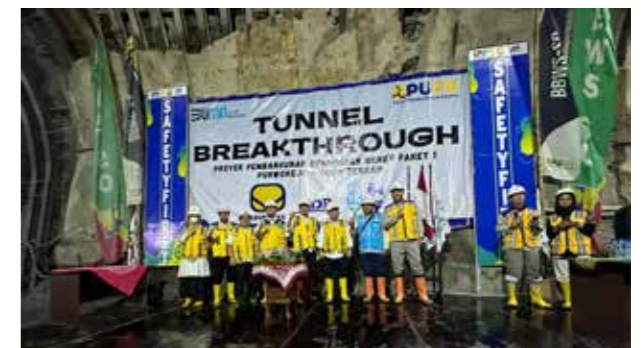
Tunnel breakthrough Bendungan Bener, bendungan yang akan menjadi bendungan tertinggi di Indonesia pada 8 Mei 2023.
