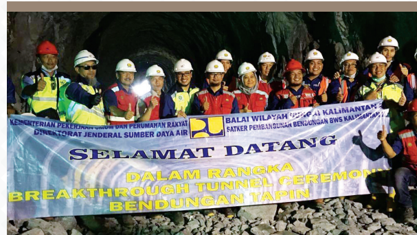
▶ Abipraya berhasil melakukan breakthrough tunnel Bendungan Tapin. Bendungan ini masuk dalam program prioritas pembangunan bendung Indonesia pada 15 September 2017
