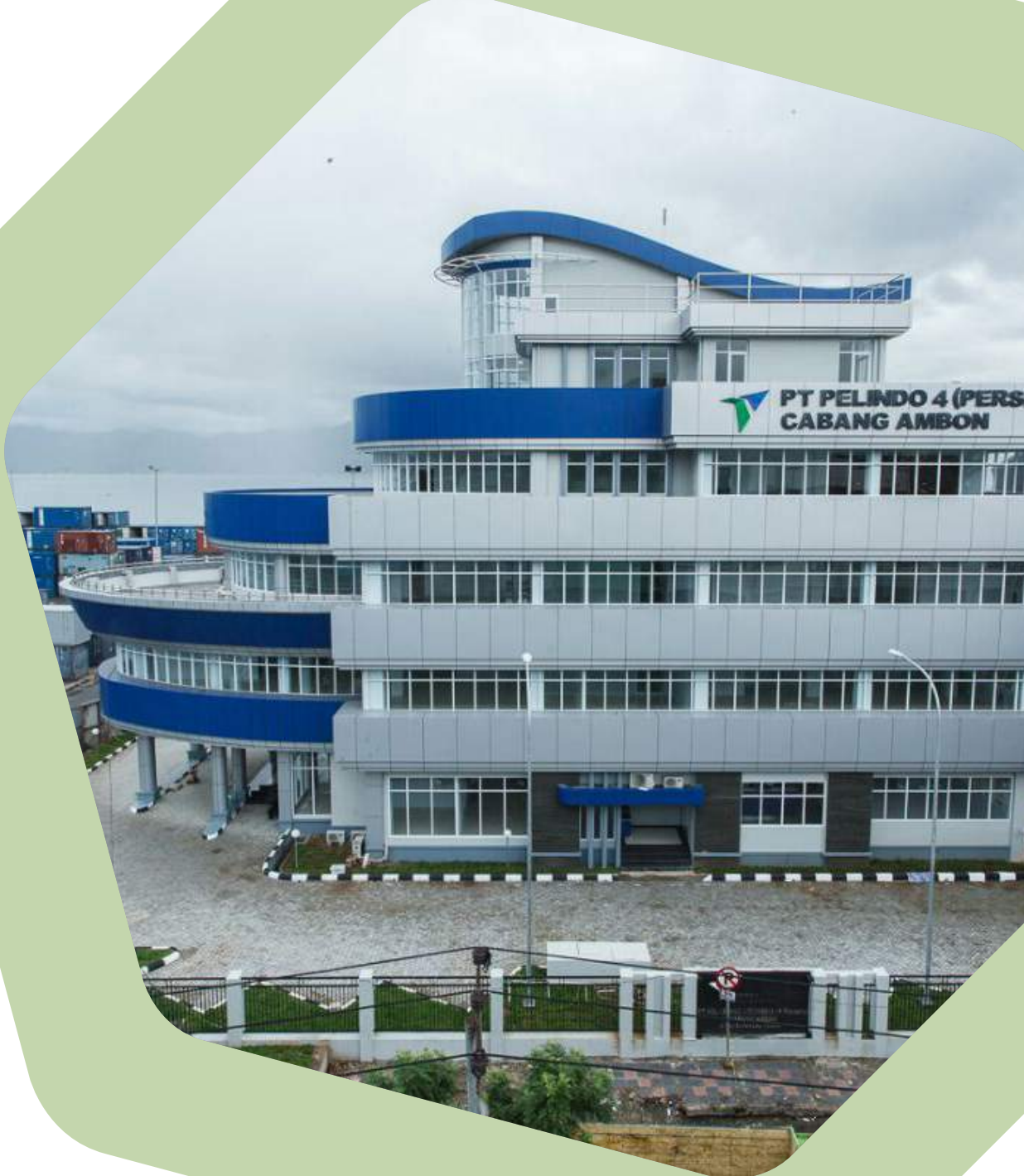
Proyek Pembangunan Kantor Pelindo 4 Cabang Ambon, Maluku Pelindo 4 Ambon Branch Office Project, Maluku
